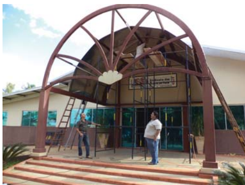
Troca cobertura de lona por metálica
