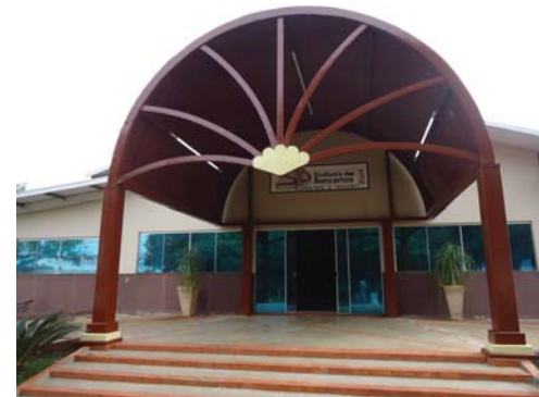
Cobertura da entrada finalizada
