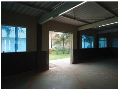
Abertura para nova saída de emergência
