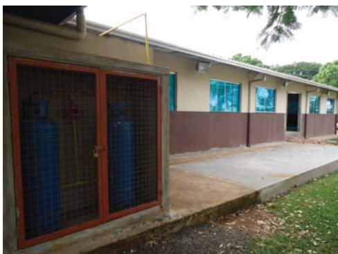
Instalações de gás industrial para a cozinha com laudo de estanqueidade
