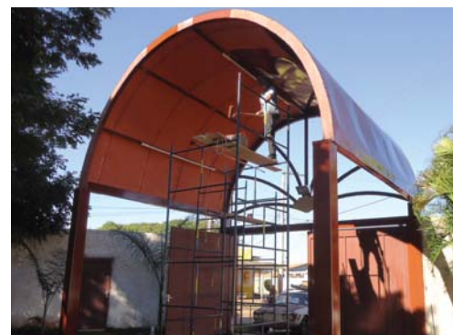
Pintura da nova estrutura metálica
